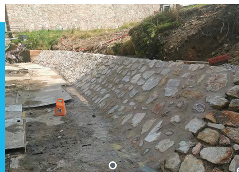
- les nettoyage et rejointoiement des maçonneries de l'épanchoir 1 (achevés) et celles de l'épanchoir 3 (à engager sous les 12m50) qui s'achèveront en octobre (photo 6),
