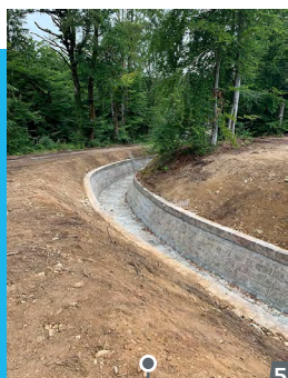
- le rehaussement des parois de l'évacuateur de crue (achevé le 27 juillet) (photos 4 et 5),
