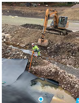
- la construction du batardeau amont (photo 1),
