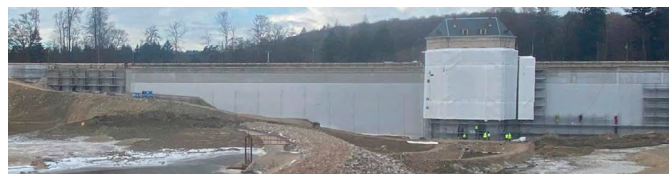
Barrage des Settons fin 2022, avant remplissage - Parement amont
