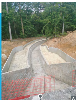
- le rehaussement des parois de l'évacuateur de crue (achevé le 27 juillet) (photos 4 et 5),
